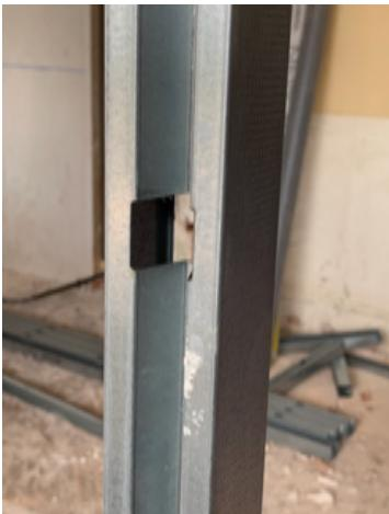
Trasdosados en toda la fachada por el interior con BA13, tabiquería de PYL con sistemas de aislamiento acústico con dobles placas a cada lado de PLACO PHONIQUE 15, montantes específicos del sistema METALPHONIQUE STILL, aislamiento acustico en el interior de los tabiques
