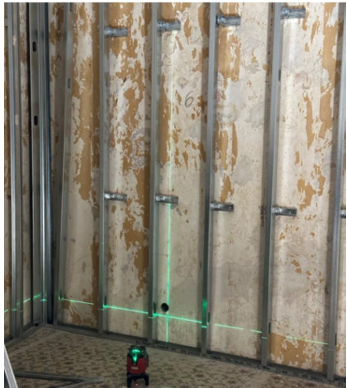
Una vez asegurada la estructura y rigidizando los entramados, procedimos a realizar un trasdosado autoportante en la totalidad de la vivienda. Se realizó en doble placa con aislamiento térmico acústico en todo su perímetro y techos
