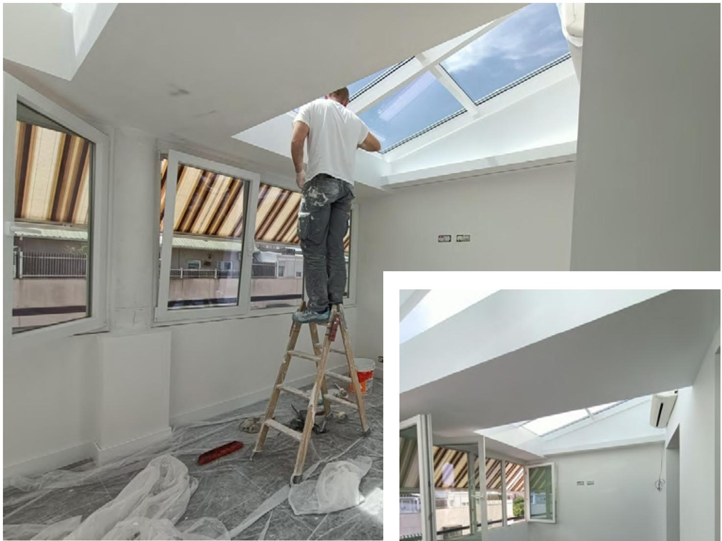
Toda la terraza se suma a la vivienda, se cierra mediante un muro cortina de vidrio inclinado y todo el frontal con ventanas en pvc oscilobatientes. Se climatiza mediante suelo radiante refrescante. Para reforzar la climatización en verano, se instala una unidad de split en pared
