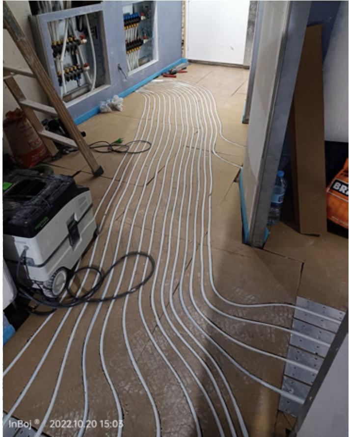
El sistema PowerFloor de Wolf Bavaria nos permite realizar un suelo radiante con sistema seco ahorrando así tiempos de secado. Es un sistema muy recomendable para acabados finales como tarimas tanto flotantes como adheridas
