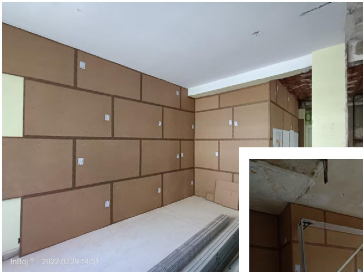
Los paneles de PhoneStar Tri se colocan en las medianeras con taco de impacto y contrapeados
