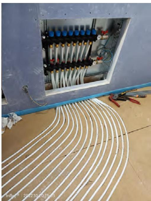
El sistema PowerFloor de Wolf Bavaria consiste en distintas capas hasta formar un doble suelo flotante. Por un lado tenemos las placas PhoneStar Tri de Wolf, posteriormente instalamos los paneles de PowerFloor que a su vez están adheridos al PhoneStar y posteriormente colocamos una lámina desolidarizante
