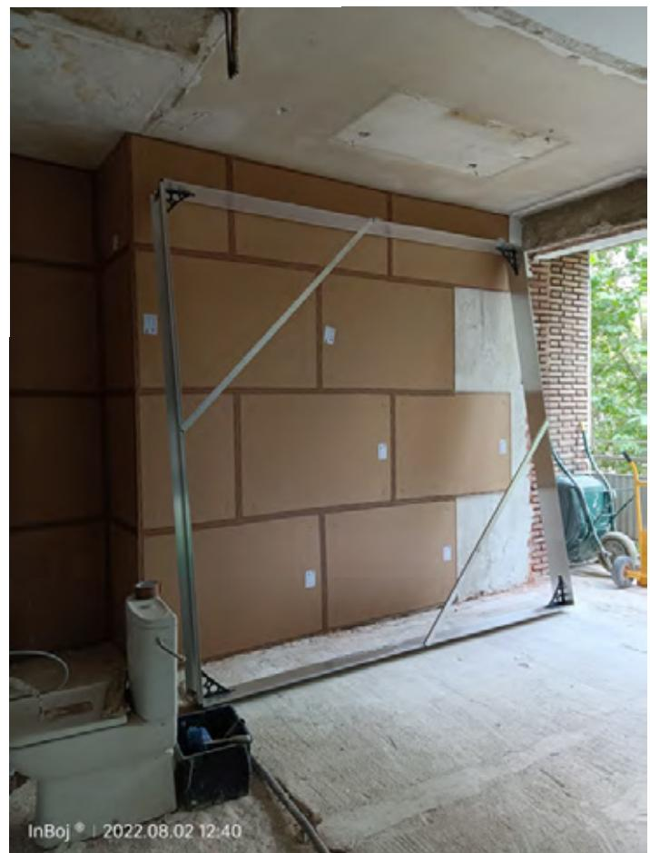
Se consideran dos tipos de aislamiento acústico/térmico, por un lado el tratamiento de elementos verticales que son medianeras con otras viviendas donde se instala PhonStar Tri y a continuación un tabique autoportante de 46mm con doble placa Diamant de la firma Knauf y aislamiento de la firma Ursula
