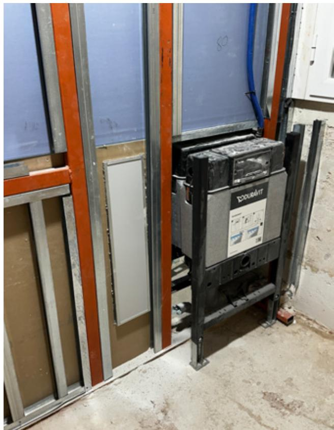
La complejidad de los baños era muy alta debido a la cantidad de elementos e instalaciones que había que realizar en tan poco espacio, por ello se creó una estructura de tubo de acero anclada de forjado a forjado donde fijar toda la tabiquería de Knauf Diamant así como los inodoros suspendidos y la soportación de los lavabos
