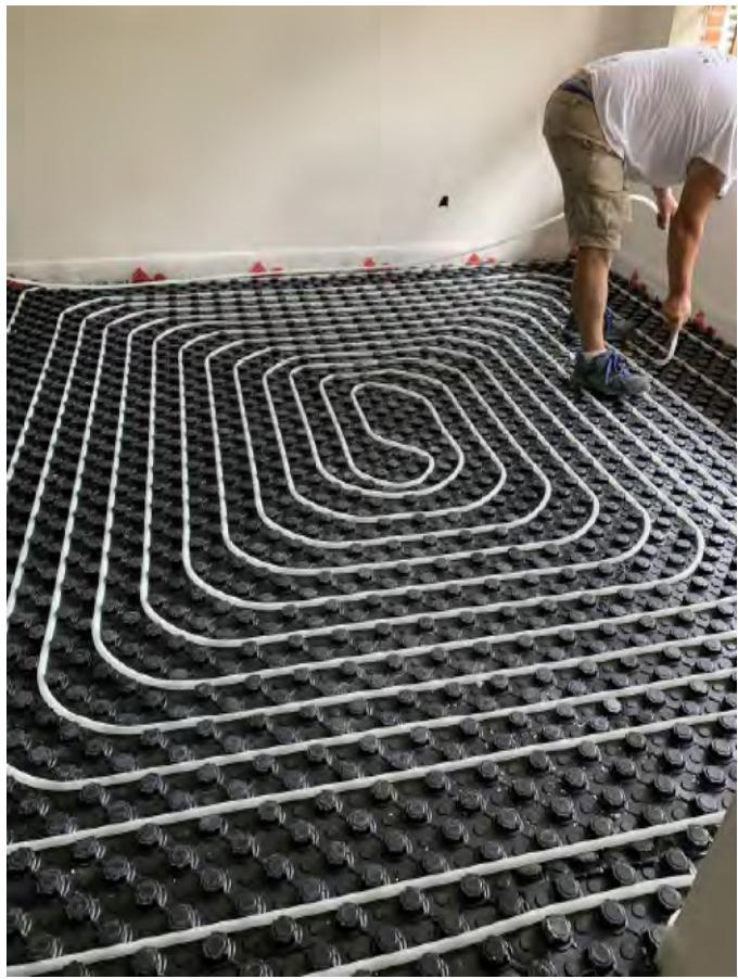
Instalamos suelo radiante refrescante de SAUNIER DUVAL con sistema de aerotermia Genia Max
