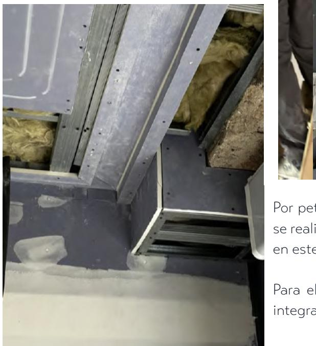
Por petición del cliente, se diseñaron multitud de cortineros y foseados que se realizaron por control numérico en el mismo material que el resto del techo, en este caso Knauf Diamant de 15mm
