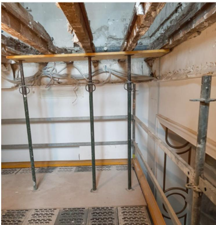
Al descubrir el forjado, observamos que la mayoría de las vigas de madera han perdido su capacidad estructural, procediendo a apuntalarlas sobre una estructura intermedia de plataformas ubicada en la planta inferior
