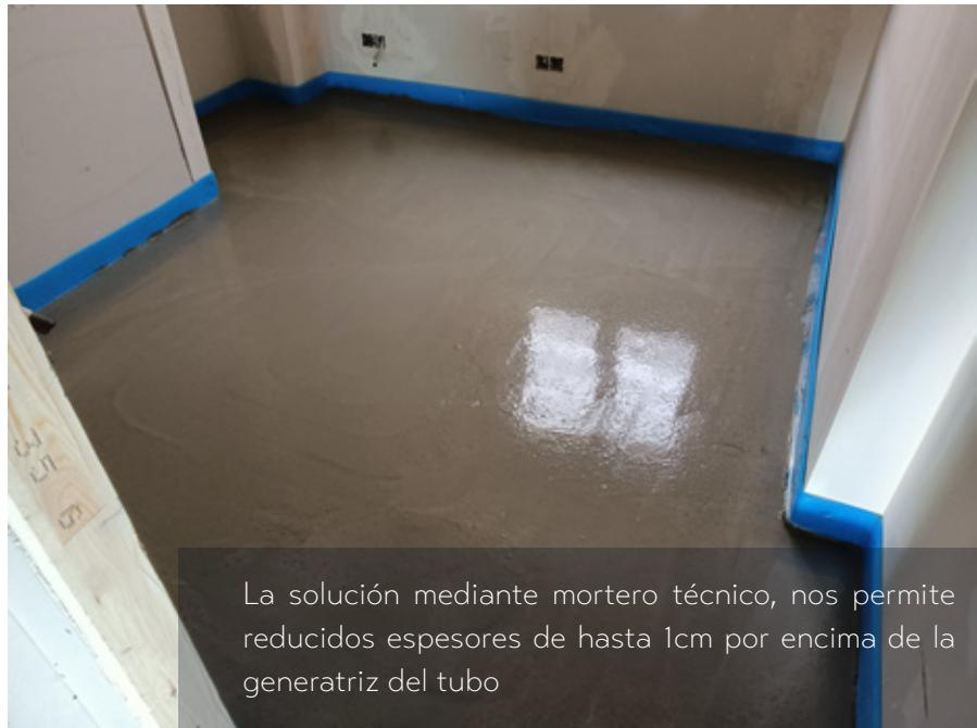
La solución mediante mortero técnico, nos permite reducidos espesores de hasta 1cm por encima de la generatriz del tubo
