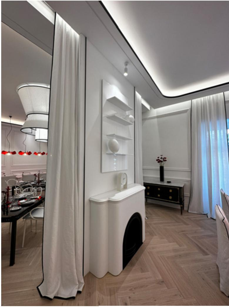
La construcción del doble tabique con chapa plegada sirvió para alojar y recoger todo el sistema de cortinas.
